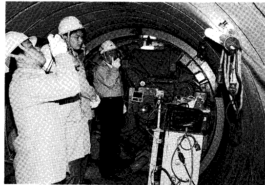
施工中の管内を先導体(掘進機)の後部まで公開した
