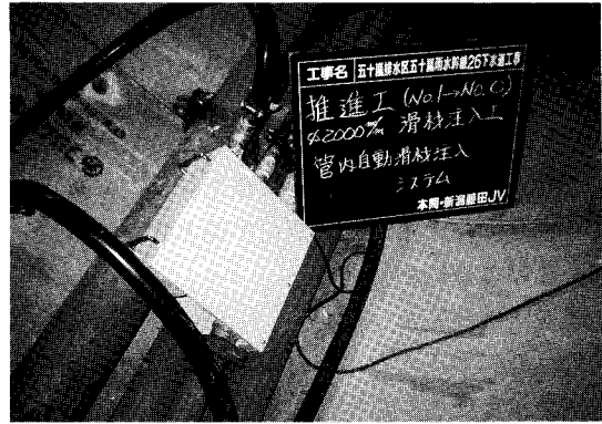
写真-2 アルティミット滑材充填システム (ULIS)
