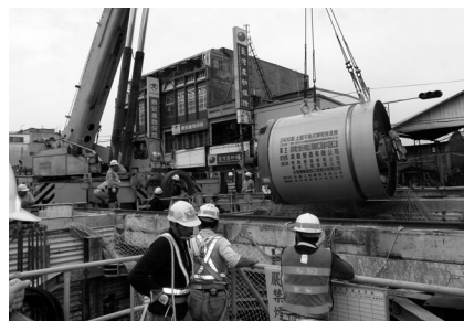
写真-1 掘進機吊降
