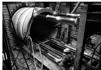
写真-2 元押ジャッキ上下配置
