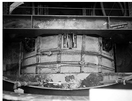
写真-4 固定治具取付け
