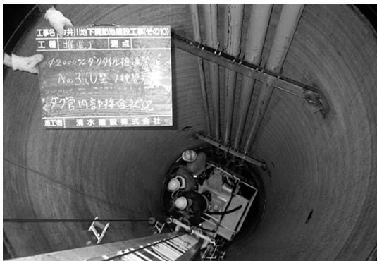
写真-6 管内作業状況
