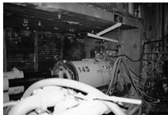
写真-1 ステーション内推進状況（発進坑口側）
