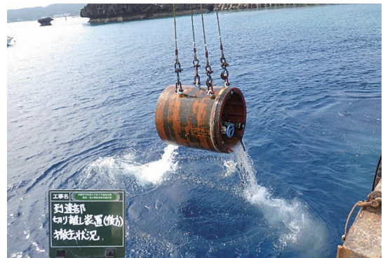
写真-10 第2隔壁筒回収状況
