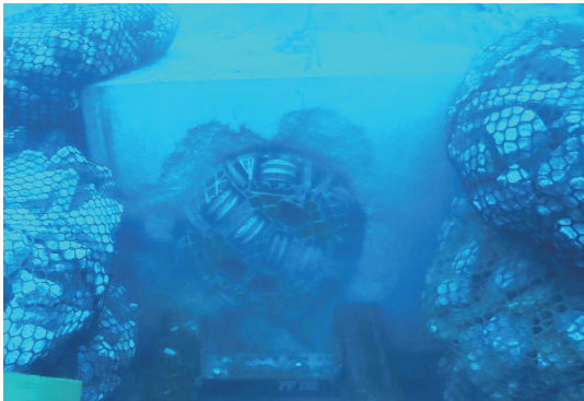
写真-7 掘進機到達状況
