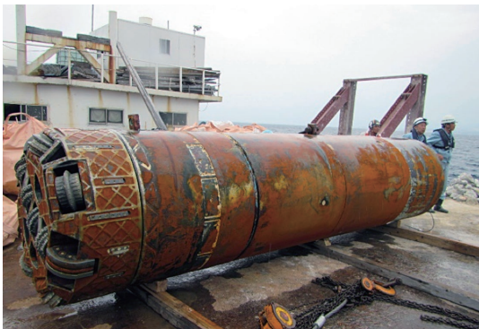
写真-8 掘進機+第1隔壁筒回収完了
