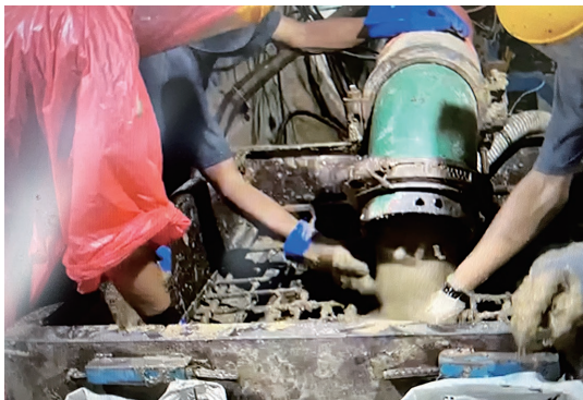
写真-6 玉石取除き作業状況
