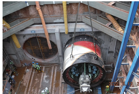
写真-3 1号機の据付
