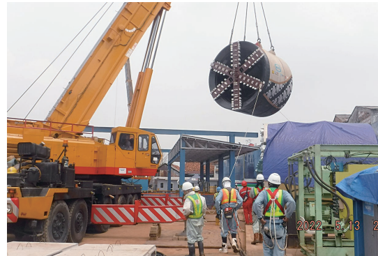
写真-2 1号機の投入
