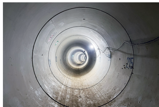
写真-8 サウスラインの推進管内の曲線状況
