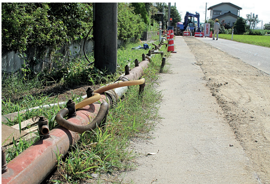
写真-6 ウェルポイント施工状況
