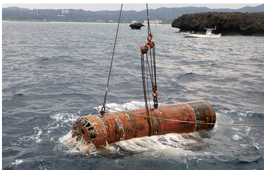
写真-10 掘進機水中回収状況
