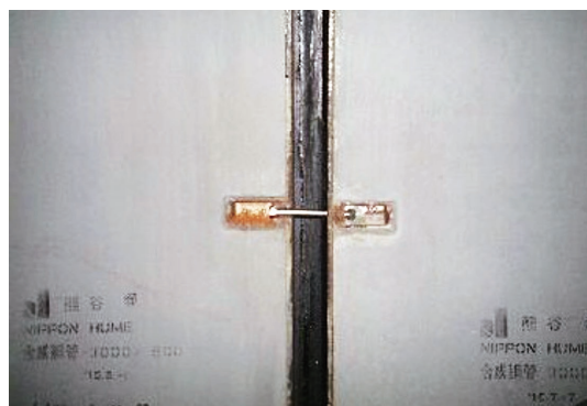
写真-8 目地開口制限装置
