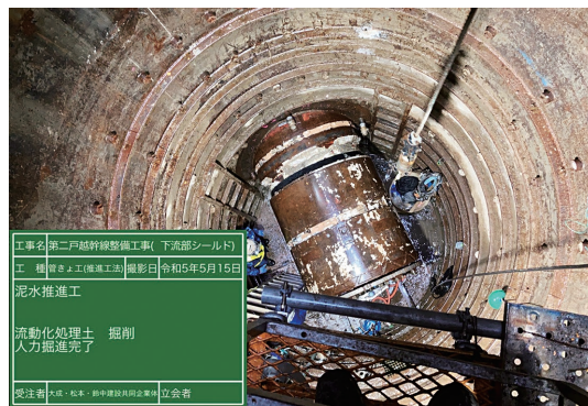
写真-2 掘進機回収の様子
