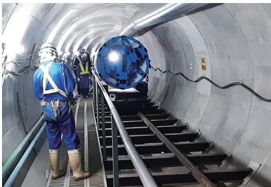
写真-4 掘進機運搬状況
