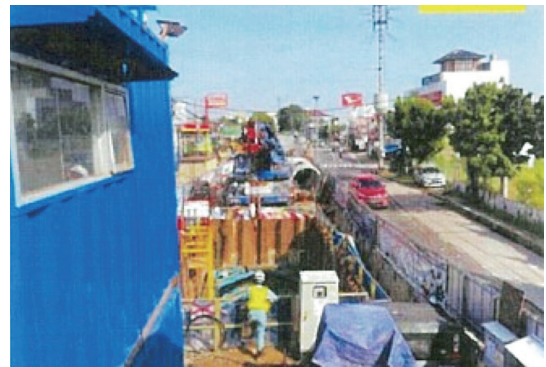
写真-10 現場占有状況
