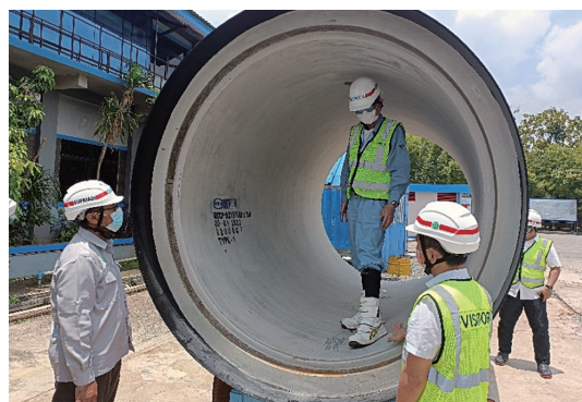
写真-4 推進管品質確認状況
